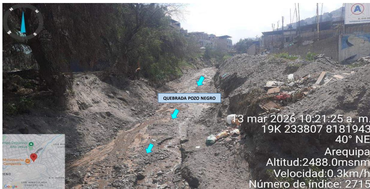
IMAGEN 02: EN ESTE TRAMO SE OBSERVA EN AMBAS MÁRGENES DE LA QUEBRADA POZO NEGRO, SE ENCUENTRA SIN PROTECCIÓN, Y SU CAUCE SE ENCUENTRA COLMATADO DE SEDIMENTO; Y EXISTEN VIVIENDAS CERCA A SU CAUCE.
